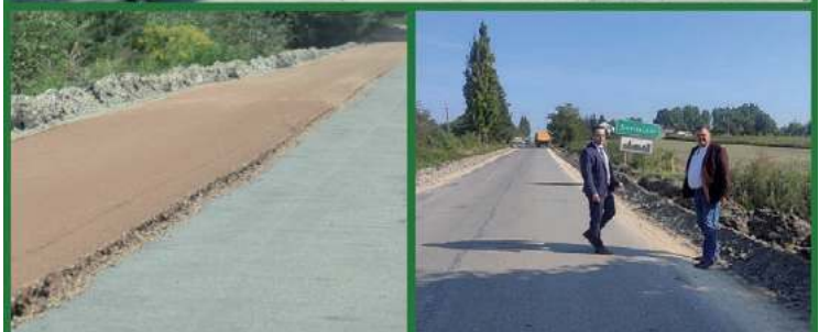
Przebudowa drogi powiatowej na odcinku Srebrzyszcze-Gotówka
