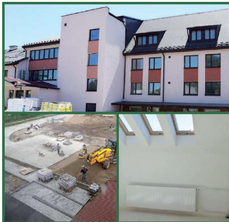
Adaptacja budynku szkolnego na Dom Pomocy Społecznej w Rejowcu
