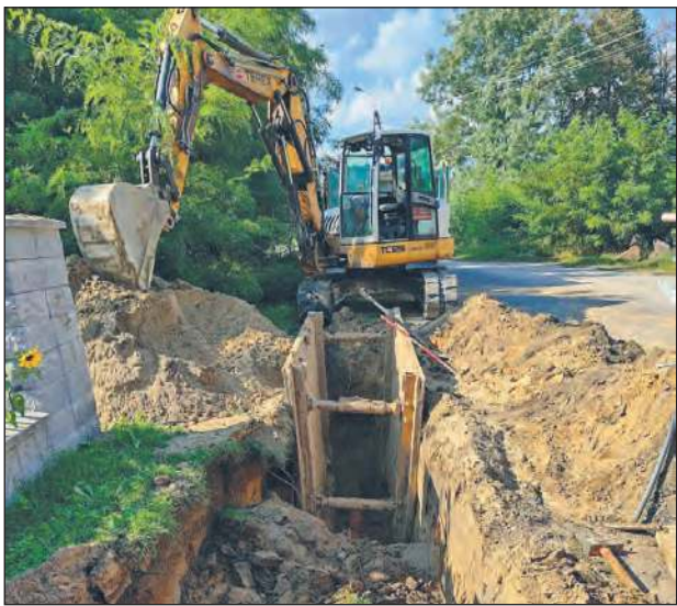
☛ Prace będą prowadzone do końca roku w rejonie ulic Kolejowa - Żytńia - Klonowa - Przychodnia wraz z przejściem pod rzeką Promnik i włączeniem do przepompowni ścieków na ul. Polnej/Andersa
