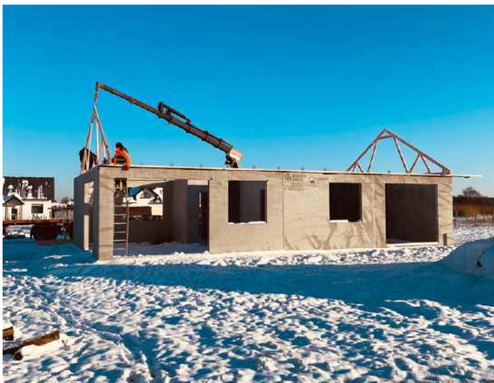
📍 Budowa domu prefabrykowanego z żelbetu. FLIXHOME
