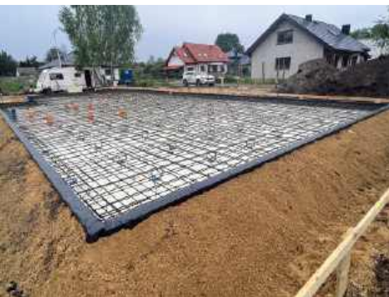
📍 Płytę fundamentową oraz roboty towarzyszące wykonuje się zazwyczaj w ciągu jednego tygodnia. T. RYBARCZYK
