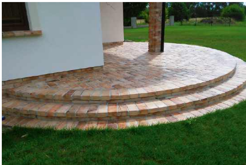
📍 Taras nie powinien być zbyt mały. Minimum zapewniające wygodne użytkowanie to 15–20 m 2 . ELKAMINO DOM
