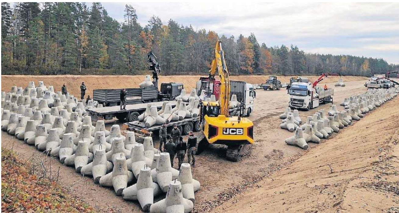
Umocnienia „Tarczy Wschód” to nie tylko fizyczne zapory (na zdjęciu), ale i zaawansowane systemy elektroniczne
