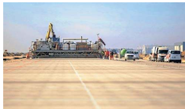
Prowadzone prace nie wpływają na zdolności operacyjne lotniska w Jasionce
