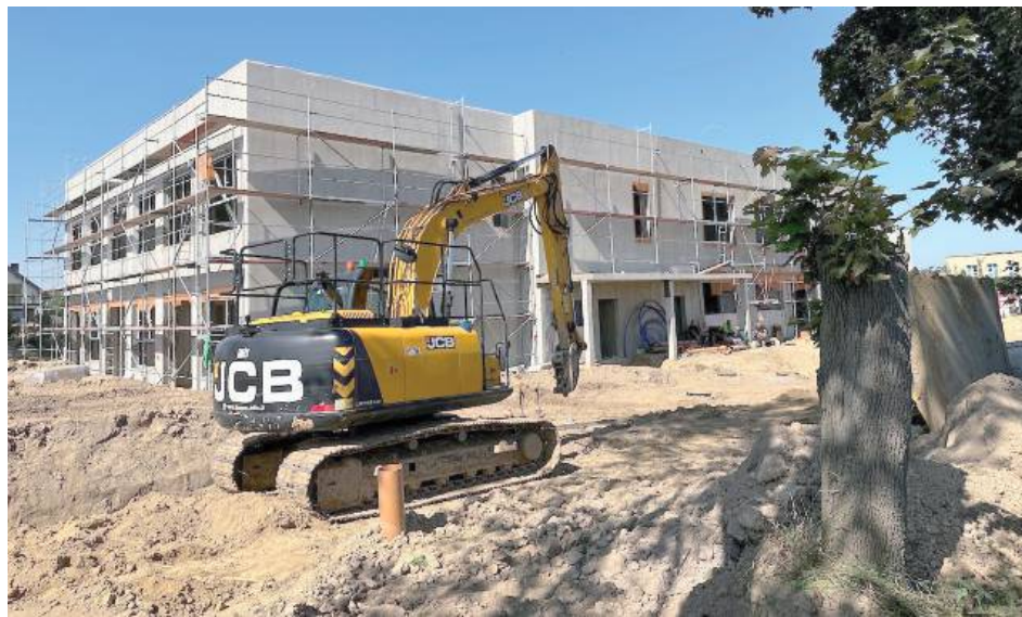
Trwa rozbudowa SP w Jakubowicach Konińskich. Prace są zaawansowane, ale na dokończenie inwestycji potrzeba jeszcze od 8 do 10 mln złotych
