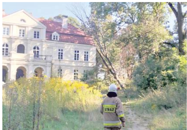
Na teren pałacu wkroczyli też strażacy, którzy usunęli powalone z dachu zabytku. Leżało tak od wielu miesięcy
