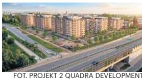
FOT. PROJEKT 2 QUADRA DEVELOPMENT
