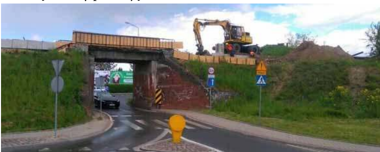
W związku z remontem wiaduktu na ul. Różanej ruch w tym miejscu został zamknięty
