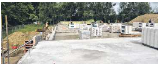
Trwają prace przy budowie nowej szkoły podstawowej
