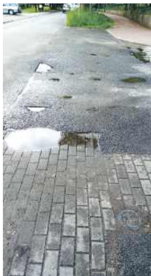
Ul. Żeromskiego, Wyżłobienia w asfalcie przez co droga wjazdowa jest mniej przyjazna
