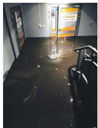
Budynek basenu po ulewie
