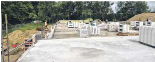
Trwają prace przy budowie nowej szkoły podstawowej
