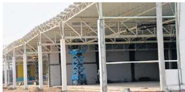
Budowa galerii S1, która powstaje w miejsce dawnego Tesco przy ul. Majkowskiej w Kaliszu nabiera tempa.
