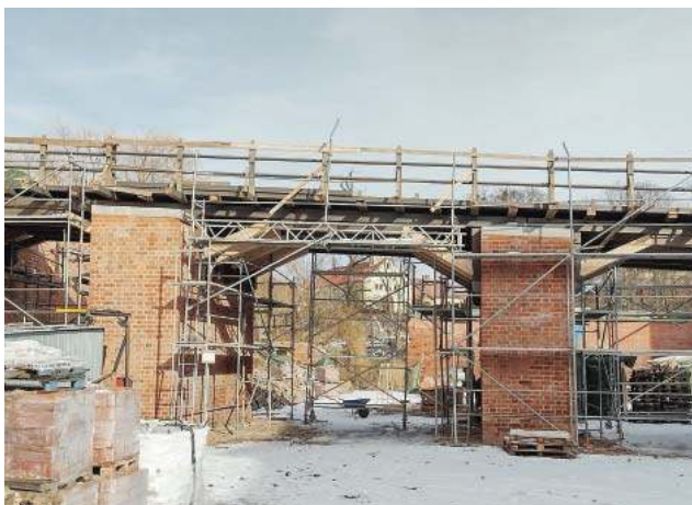
Rozebranie starego i budowa nowego mostu to tylko jeden z elementów dużego projektu
