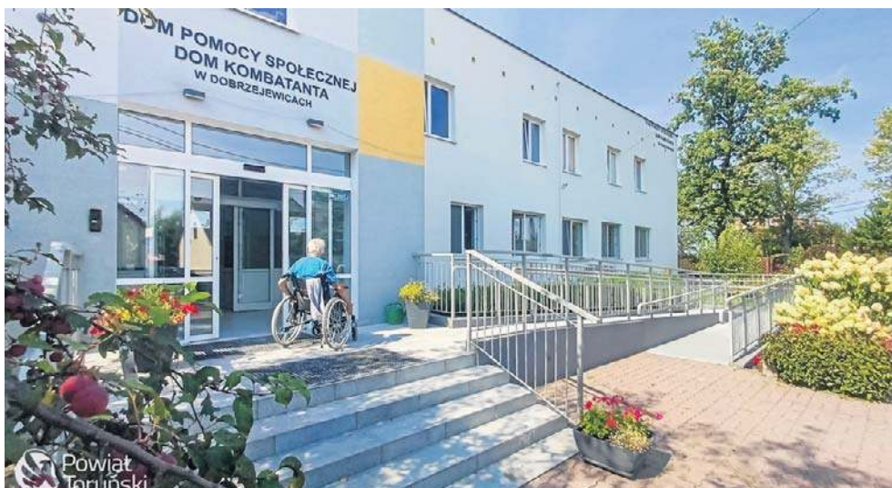
W 2025 roku ukończono rozbudowę i modernizację DPS-u w Dobrzejewicach
