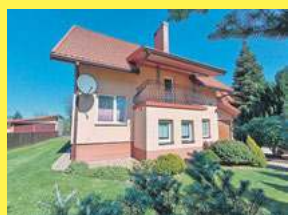
Dom przy ulicy Wyzwolenia, pow. 157,60 m 2 , 604 494 489
