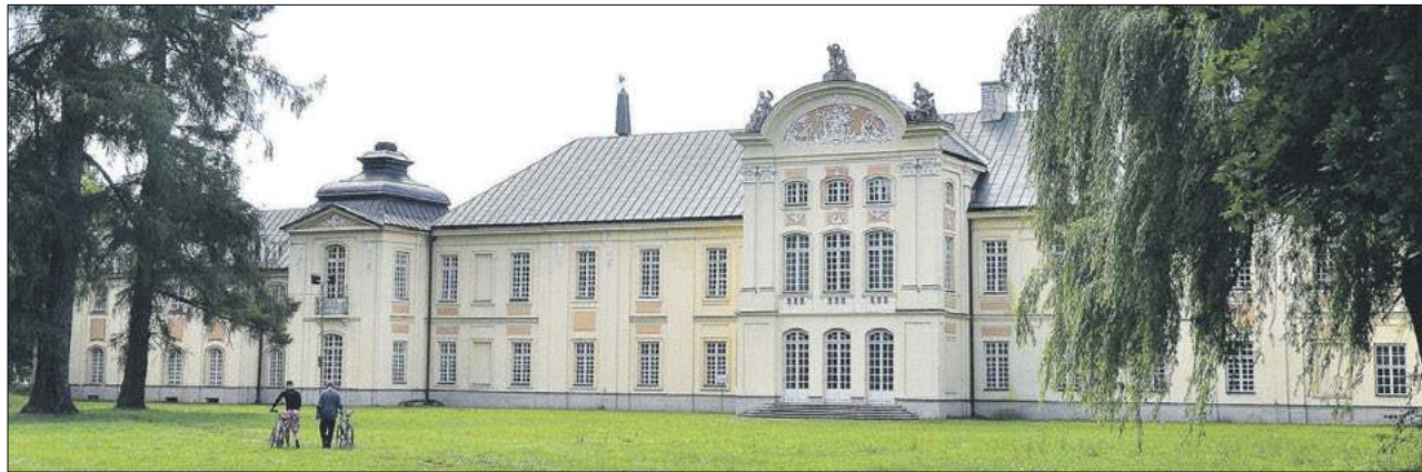
W zabytku doszło do dwóch awarii sieci wodociągowej. Na tym nie koniec, bo tuż przed nowym rokiem do burmistrza dotarły zdjęcia odpadającej elewacji na pałacowej ścianie.
