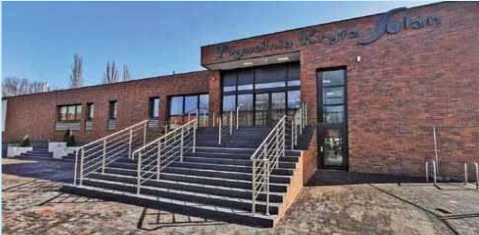
Prace przy budowie Pływalni Krytej Solan dobiegły końca (fot. UM)
