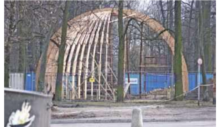
W parku Odry widać już konstrukcję muszli koncertowej
