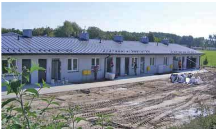
Czwarty budynek socjalny. Inwestycja kosztowała 1,5 mln zł
