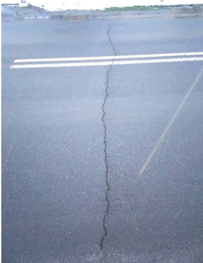
Na przebudowanym odcinku ulicy Kraczewickiej w Poniato- wej po pięciu miesią- cach od położenia nowej nawierzchni popękał asfalt. Na 80 metrach mieszkańcy nalazli osiem spękań
