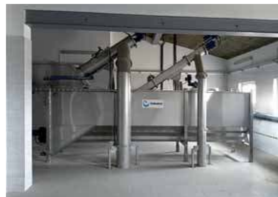
Zamontowany sitopiaskownik w nowym pomieszczeniu hali
