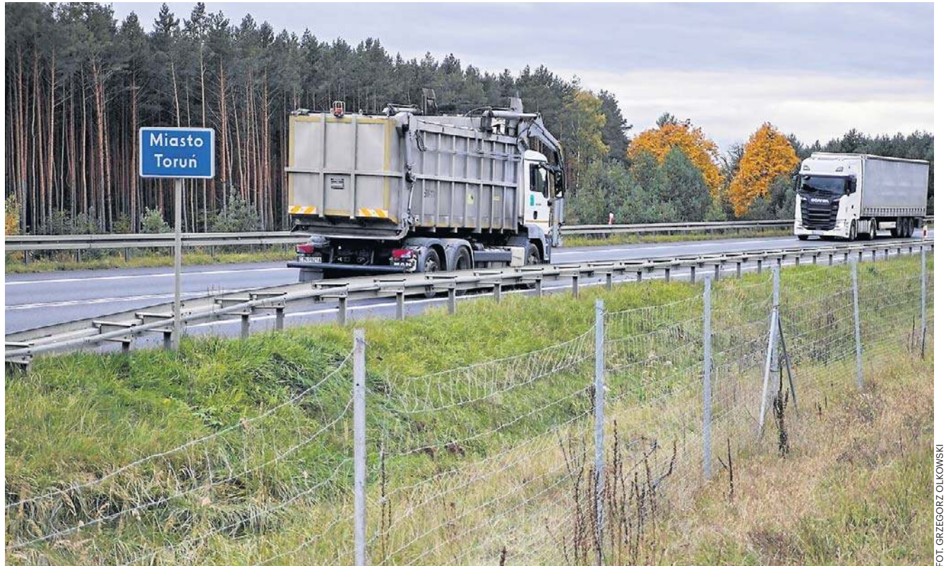
Wiosną 2026 r. powinna w końcu rozpocząć się budowa 12-kilometrowego fragmentu trasy ekspresowej S10 między węzłami Toruń Zachód a Toruń Południe. To część większej inwestycji - budowy tej drogi między Bydgoszczą a Toruniem
